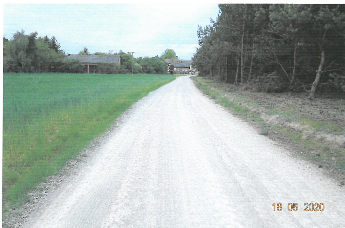
Nr 2. Widok na szerszy fragment drogi w km 0+150 (w kierunku Bukowca)
